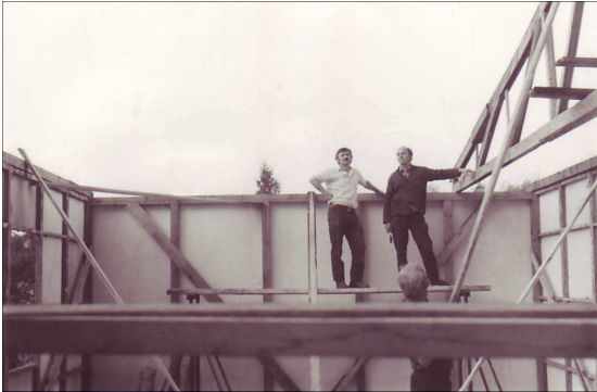
Errichtung der Dachbinder von den Zfrd. Erhard Schaarschmidt und Jürgen Beck
