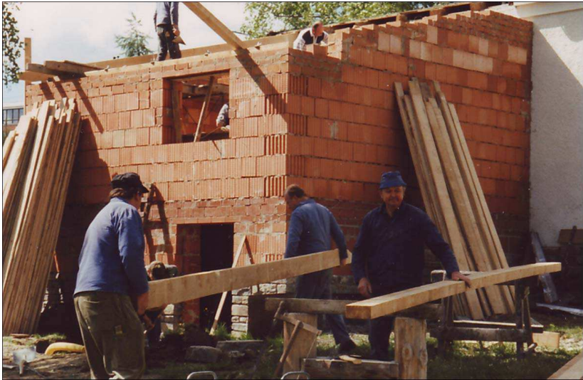
Zuchtfreunde Jürgen Beck und Siegfried Bayer bei Dachstuhlarbeiten vor dem Richtfest
